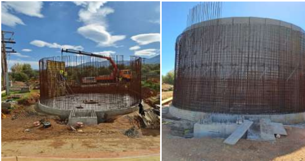
ΕΕΛ Μαλίων κατασκευή βαρυτικού παχυντή με σύστημα ανάδευσης: (α) έναρξη καλουπώματος τοιχίων, (β) ολοκλήρωση εσωτερικών καλουπιών
