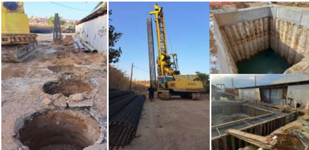
Αντλιοστάσιο ΑΣ2 στην περιοχή Κοκκίνη: κατασκευή πασσάλων μήκους 17m με κεφαλόδεσμο
