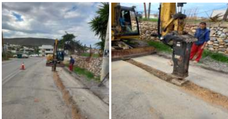
Δίκτυο ύδρευσης Γουρνών: εργασίες στην παλαιά εθνική οδό (ΠΕΟ) εντός ορίων οικισμού
