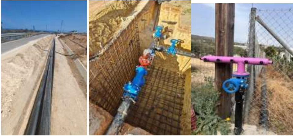
Δίκτυο διάθεσης επεξεργασμένης εκροής ΕΕΛ Γουβών: (α) εκσκαφή και τοποθέτηση αγωγών, (β) σιδέρωμα φρεατίου μείωσης πίεσης, (γ) collector άρδευσης
