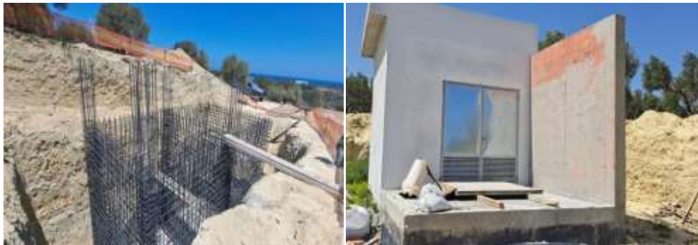
Ενδιάμεσο αντλιοστάσιο ΑΣ5 στην περιοχή νότια των Γουρνών: Ολοκλήρωση Οικοδομικών εργασιών
