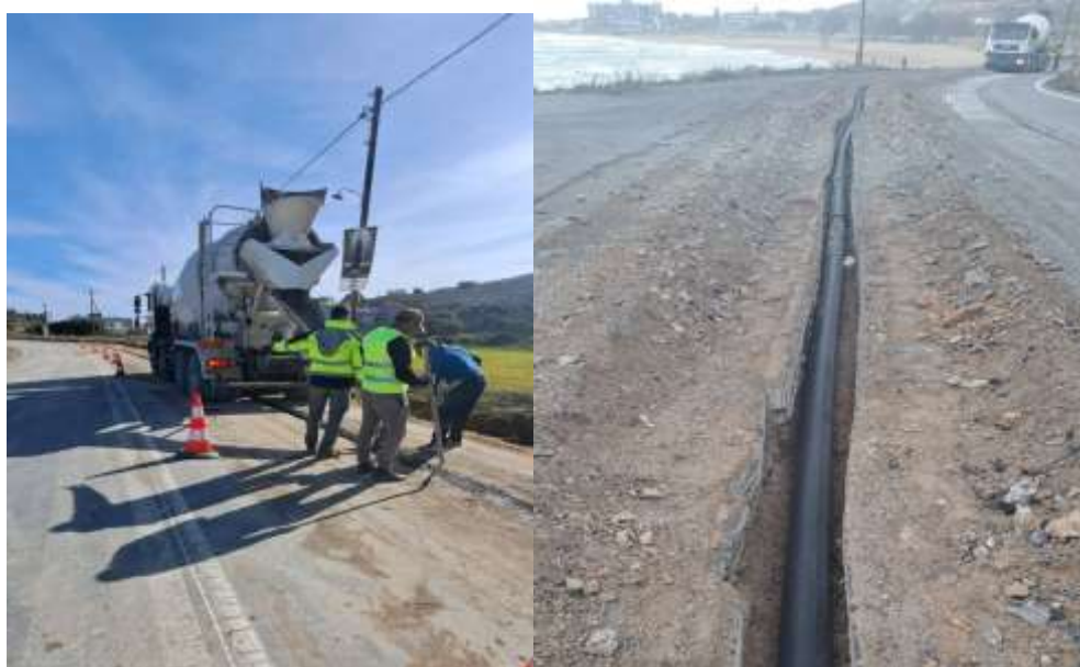
Κατασκευή Καταθλιπτικού Αγωγού στο Κακόν Όρος
