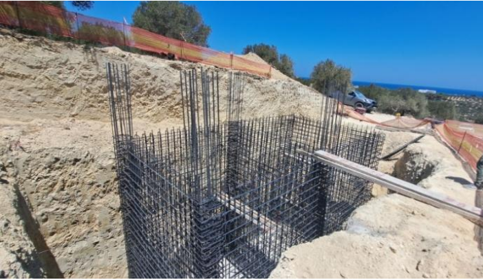
Ενδιάμεσο αντλιοστάσιο ΑΣ5 στην περιοχή νότια των Γουρνών: Ολοκλήρωση Οικοδομικών εργασιών
