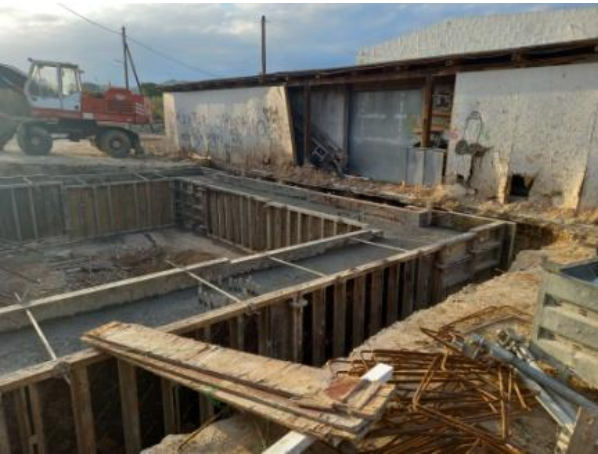
Αντλιοστάσιο ΑΣ2 στην περιοχή Κοκκίνη: κατασκευή πασσάλων μήκους 17m με κεφαλόδεσμο
