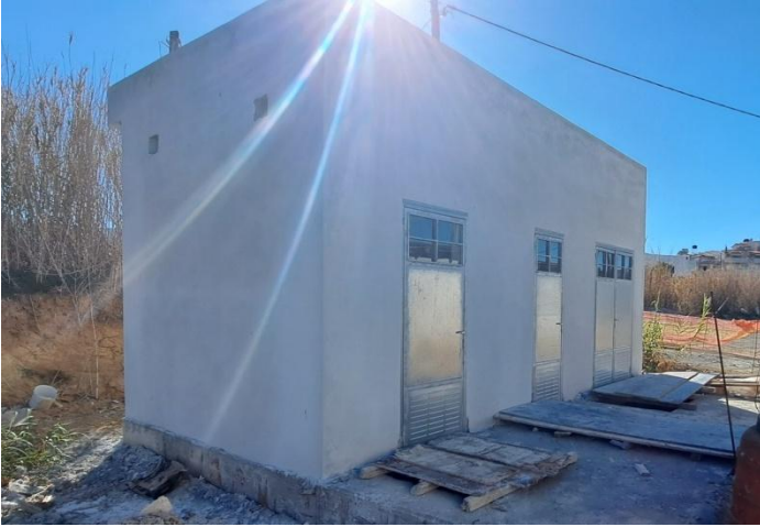
Αντλιοστάσιο ΑΣ2: Ολοκλήρωση Οικοδομικών εργασιών
