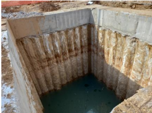
Αντλιοστάσιο ΑΣ2 στην περιοχή Κοκκίνη: κατασκευή πασσάλων μήκους 17m με κεφαλόδεσμο
