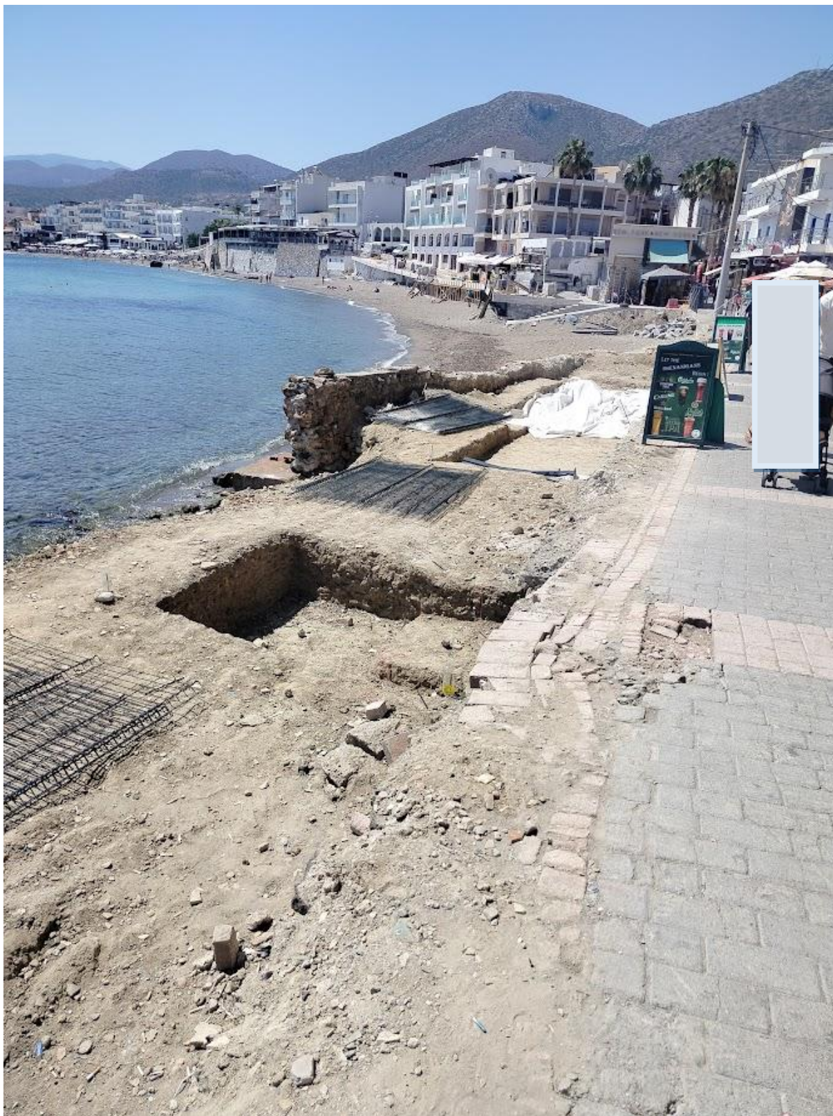
Εικόνα 3 : Άποψη από το πεδίο εκτέλεσης του έργου Ανάπλασης χερσαίας λιμενικής ζώνης Χερσονήσου
