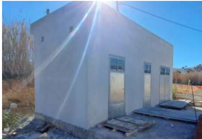
Αντλιοστάσιο ΑΣ2: Ολοκλήρωση Οικοδομικών εργασιών
