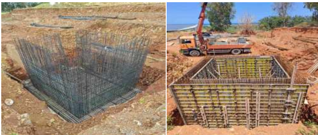
ΕΕΛ Μαλίων κατασκευή νέου αντλιοστασίου στραγγισμάτων: (α) σιδέρωμα τοιχίων, (β) έναρξη σκυροδέτησης τοιχίων
