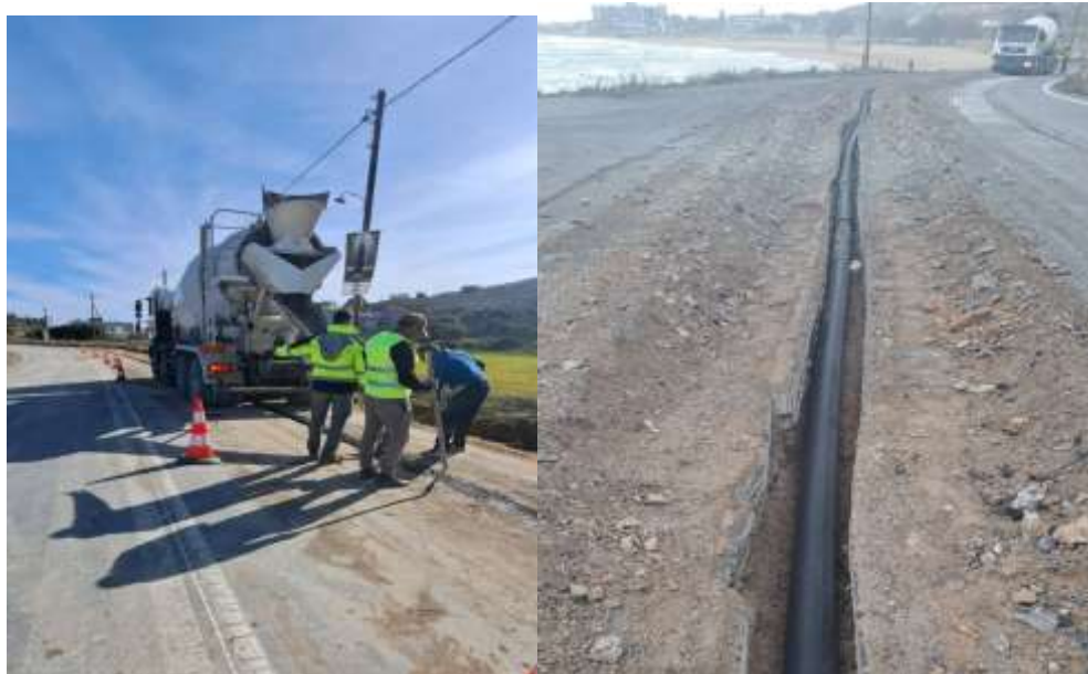
Κατασκευή Καταθλιπτικού Αγωγού στο Κακόν Όρος
