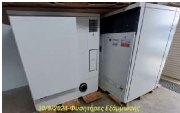
ΕΕΛ Χερσονήσου: (α) Αντικατάσταση φυγοκεντρικών διαχωριστών για αφυδάτωση ιλύος (β) Αντικατάσταση Αυτοκαθαριζόμενων Εσχάρων (ster screen), (γ) Αντικατάσταση φυσητήρων εξάμμωσης
