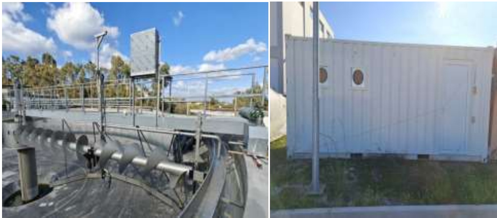
Αναβάθμιση ΕΕΛ Χερσονήσου: (α) Εγκατάσταση Γέφυρας Δεξαμενής τελικής καθίζησης, (β) Σύστημα απολύμανσης UV
