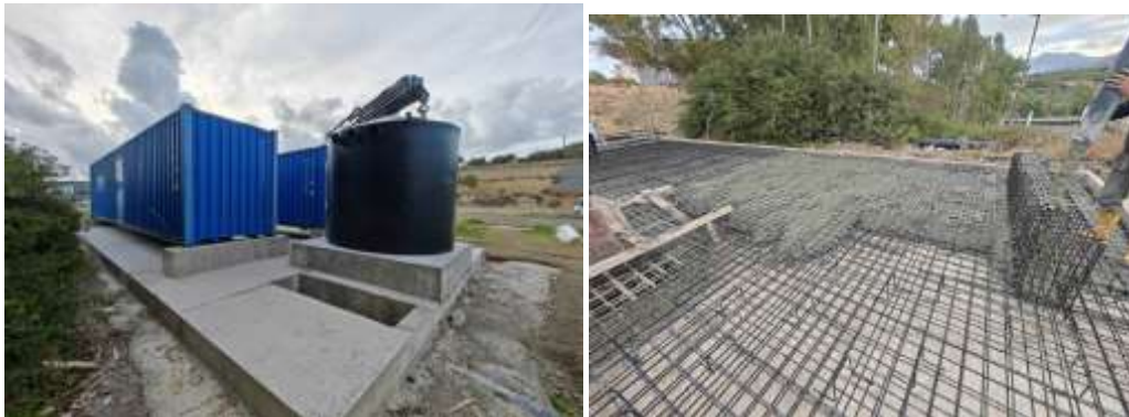
ΕΕΛ Χερσονήσου προκατασκευασμένο σύστημα υπερδιήθησης UF για βελτίωση ποιότητας εκροής: (α) σκυροδέτηση βάσης, (β) τοποθέτηση
