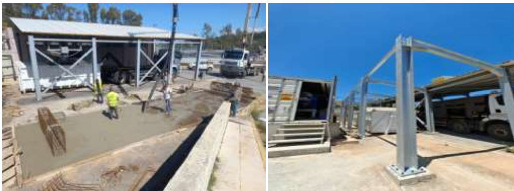
ΕΕΛ Χερσονήσου προκατασκευασμένο σύστημα φυγοκεντρικού διαχωριστή: (α) σκυροδέτηση βάσης, (β) τοποθέτηση μεταλλικού υπόστεγου
