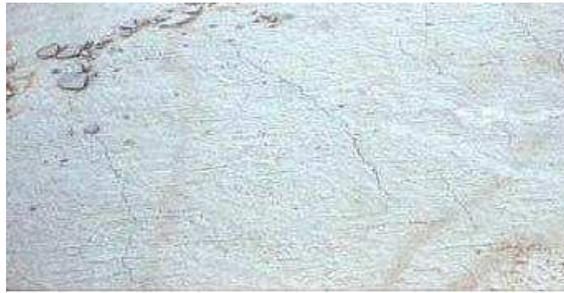
**Εικόνα 1 - Ρηγμάτωση σκυροδέματος σε πλαστική κατάσταση**
