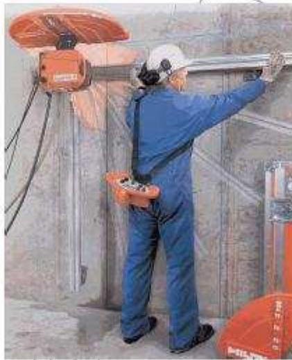
Σχήμα 2 - Κοπή τοίχου με δισκοπρίοιο επί τροχιών καθοδήγησης
