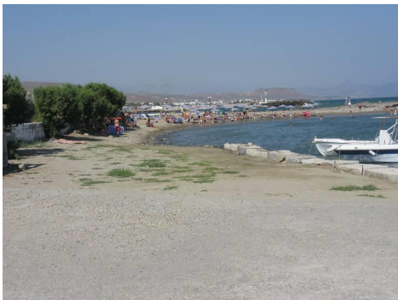
Εικ. 63: Ο μυχός τής ανατολικής "λιμενικής" εγκατάστασης, που χρησιμοποιείται από τους λουόμενους, λόγω της συσσώρευσης άμμου στο εσωτερικό της κατασκευής (φωτογραφίες Αναγνώστου 30 Ιουλίου 2012)
