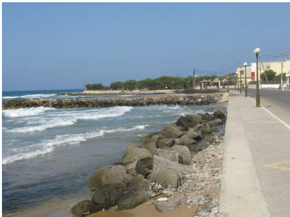
Εικ. 56: Πρόβολοι και τσιμεντένια κρηπιδώματα για προστασία της ακτής και του δρόμου από την διάβρωση (φωτογραφίες Αναγνώστου 31 Ιουλίου 2012).
