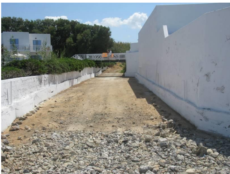
Εικ. 49: Η εγκιβωτισμένη κοίτη του ποταμοχειμάρρου στα ανατολικά του ξενοδοχειακού συγκροτήματος "Knossos Beach" (Φωτογραφία Αναγνώστου 01-Αυγ. 2012)
