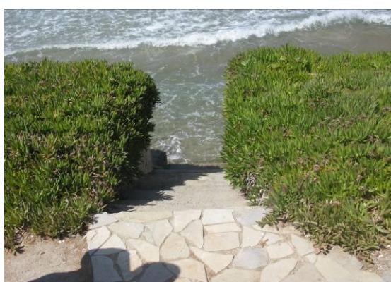
Εικ. 52: Φωτογραφίες που δείχνουν την κατάσταση της ακτής: μικρού εύρους παραλία, πρανές απειλούμενο από υπόσκαψη, λιθόρριπτο τοιχείο για προστασία του πρανούς από την διάβρωση, κλιμακοστάσια πρόσβασης στην παραλία (Φωτογραφίες Αναγνώστου 01-Αυγ. 2012).
