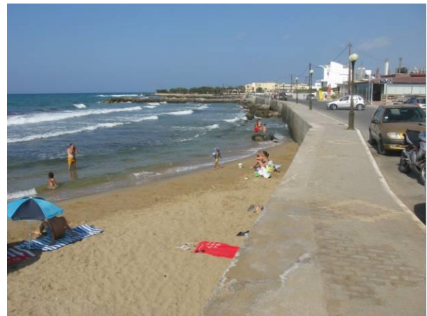
Εικ. 56: Πρόβολοι και τσιμεντένια κρηπιδώματα για προστασία της ακτής και του δρόμου από την διάβρωση (φωτογραφίες Αναγνώστου 31 Ιουλίου 2012).
