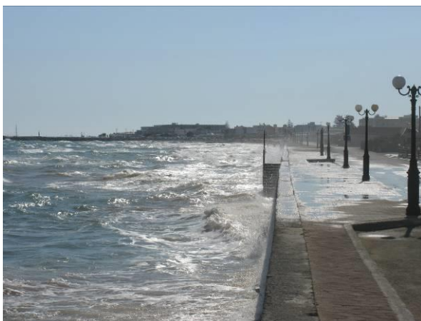
Εικ. 62.: Κρηπίδωμα αντιστήριξης του παραλιακού δρόμου στο ανατολικό μέτωπο της πρώην αμερικάνικης βάσης (αριστερά) και σχηματισμός παραλίας λόγω της κατασκευής λιθορριπτου μώλου (δεξιά) (φωτογραφίες Αναγνώστου 30 Ιουλίου 2012)
