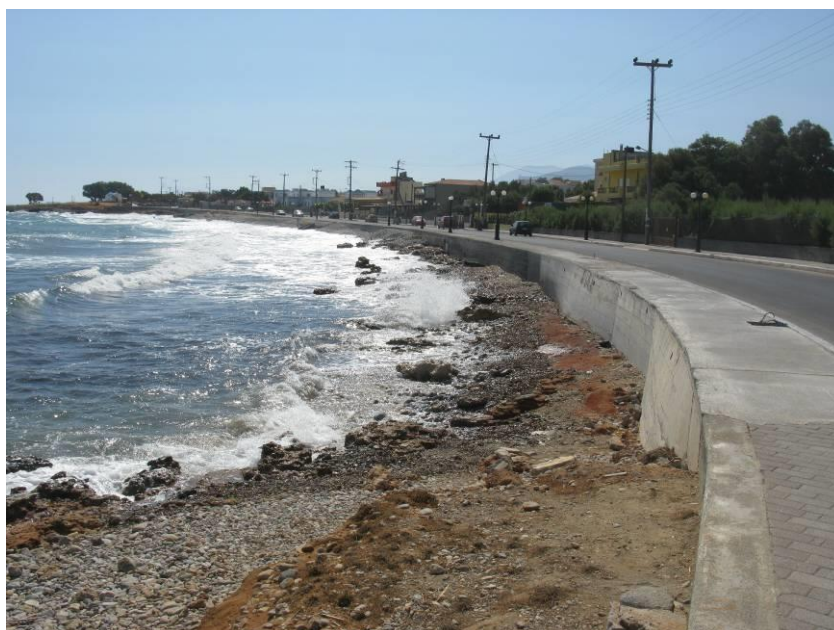
Εικ. 68: Κρηπίδωμα αντιστήριξης και προστασίας του παραλιακού δρόμου (φωτογραφία Αναγνώστου 30 Ιουλίου 2012)
