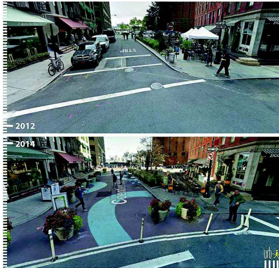
Πεζοδρόμηση, Coenties Slip, Νέα Υόρκη
